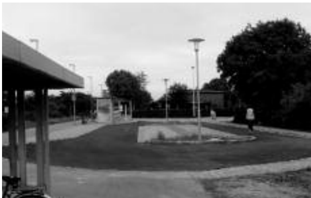
Bahnhof Süd - Anfang September war der Platz schon fast fertig.
